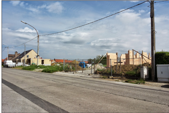
Foto 1: woningen in aanbouw thv de Langemarkstraat Bron Foto's: WVI, mei 2015
