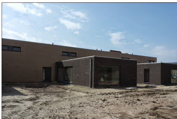
Foto 12: thv ontsluiting Albertstraat en plangebied, zuidelijk zicht (nieuwe woningen sociale huisvestingsmaatschappij) WVI | nov. '15 | VK Wallegemsgoed | 05970
