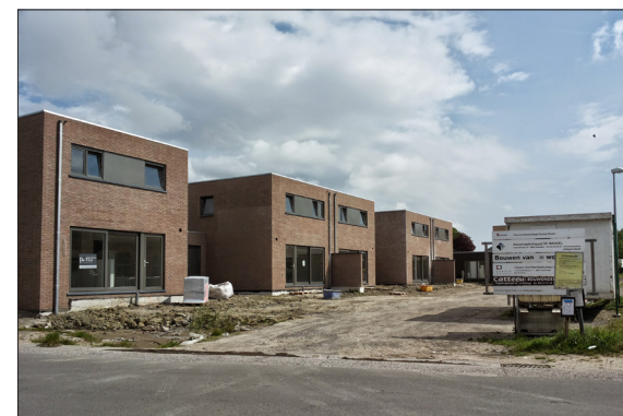
Foto 17: Langemarkstraat, thv kruising Albertstraat, oostelijk zicht.
